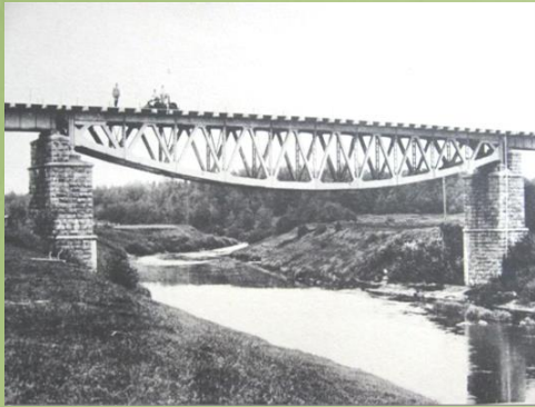
Мост через реку Торопу 1898 год
